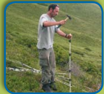
APPUI TECHNIQUE POUR L'INSTALLATION D'UN PARC
