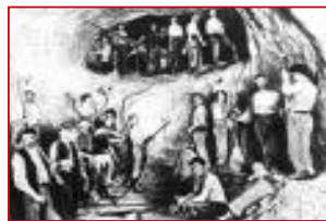
Construction de la ligne du Train Jaune : creusement d'un tunnel. (D.R.)
