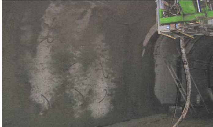
REALISATION DU VOILE FINAL EN BETON PROJETE REALIZACION DE UN REVESTIMIENTO DE HORMIGON
