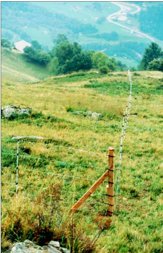
Fig. 13 : Clôture active posée dans une forte pente.
