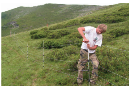
Montage de parc
