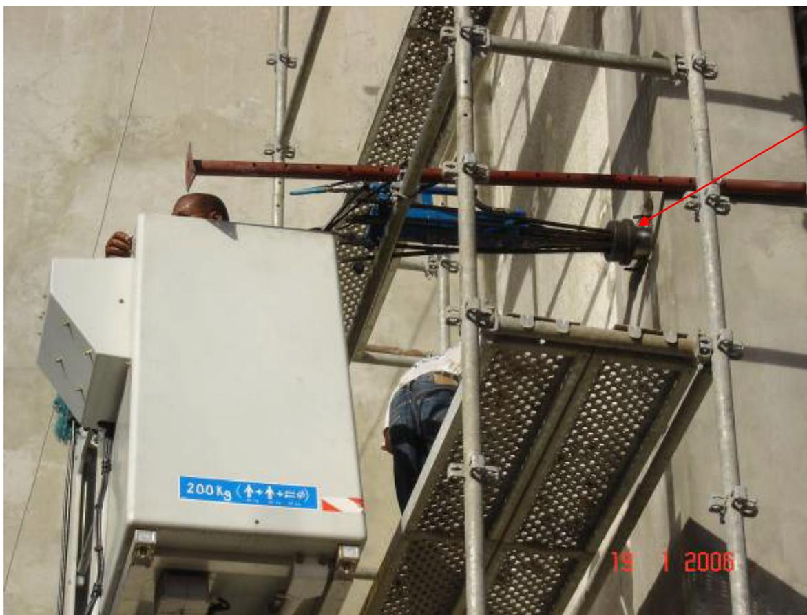
Mise en tension des câbles 6 C15 au moyen d'un vérin léger 1T15.
