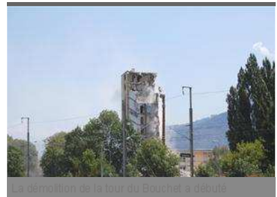
La démolition de la tour du Bouchet s'est débutée
