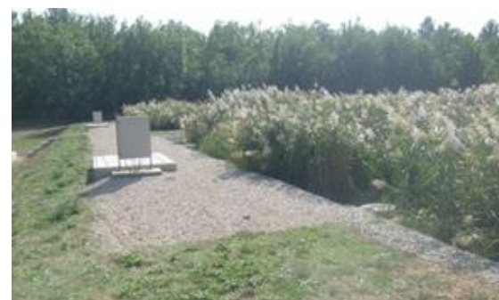
Figure 92 Photo La station d'épuration plantée de Rougiers © http://www.epurnature.fr/fr/nos-realizations/rougier
